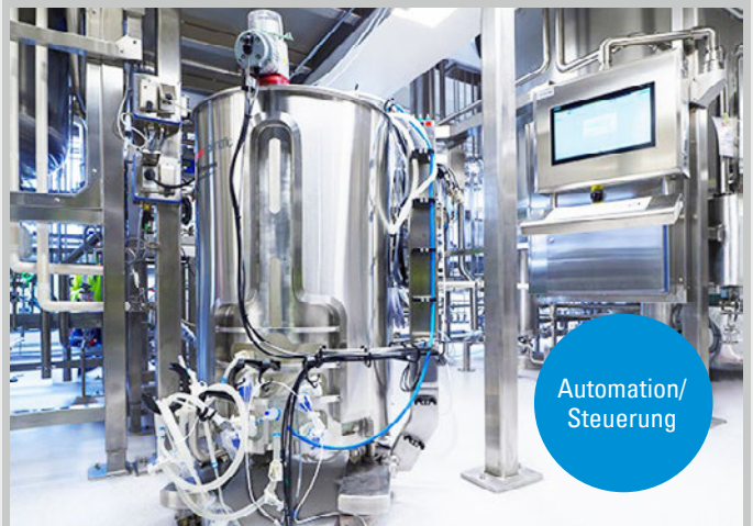
Die Steuerung des Single-Use-Reaktors (im Vordergrund) hat Bilfinger in die PCS7-basierende Steuerung der Gesamtanlage integriert. Über zwei Schnittstellen wurde die Anbindung eingerichtet und programmiert: Über eine Datenschnittstelle übermittelt der Reaktor Prozessdaten (Batch-Berichte etc.), über eine Steuerungsschnittstelle werden Grundfunktionen des Gerätes zentral gesteuert (Start/Stop etc.).
